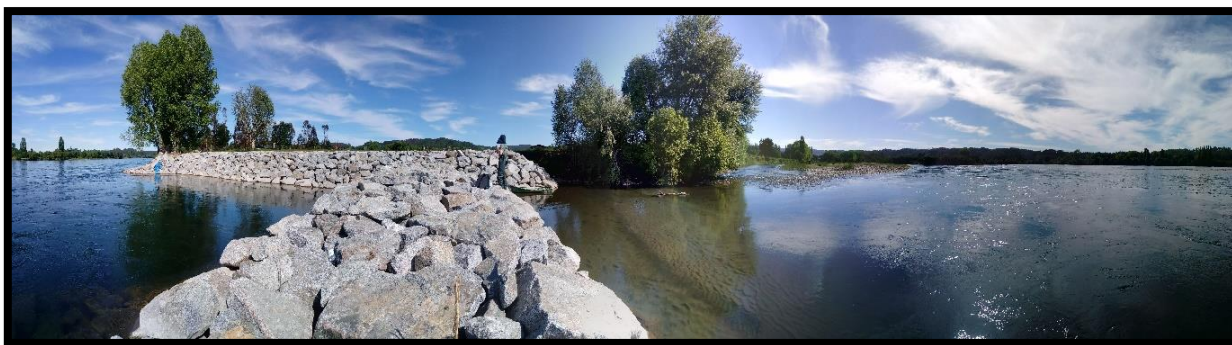
Figura 5. Vista panorámica de la obstrucción ocasionada por la construcción de la muralla y barrera construidas durante el año 2017 en el sector adyacente al sitio de muestreo ubicado en el río Calle Calle.
