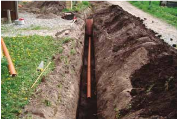
Figura 6. Excavaciones para el tendido de tuberías y de estructuras. Nótese el uso de arena para nivelación y protección.
