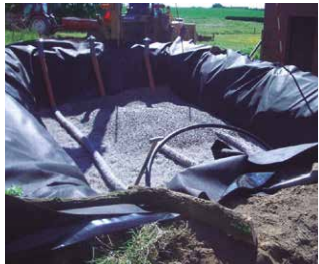
Figura 9. Dos lechos impermeabilizados con polietileno. Nótese que el material cubre las bermas de coronación.
