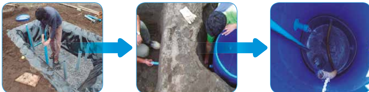
Figura 15. Estructuras de salida del agua servida tratada en el humedal construido. Fuente: Elaboración propia
