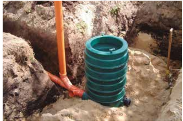
Figura 6. Excavaciones para el tendido de tuberías y de estructuras. Nótese el uso de arena para nivelación y protección.
