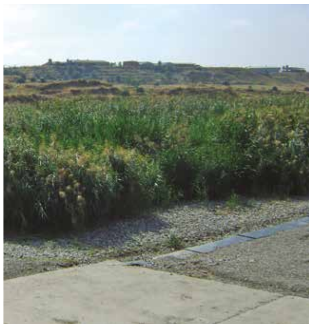
Figura 15. Vista de la PTAS Alfés.
