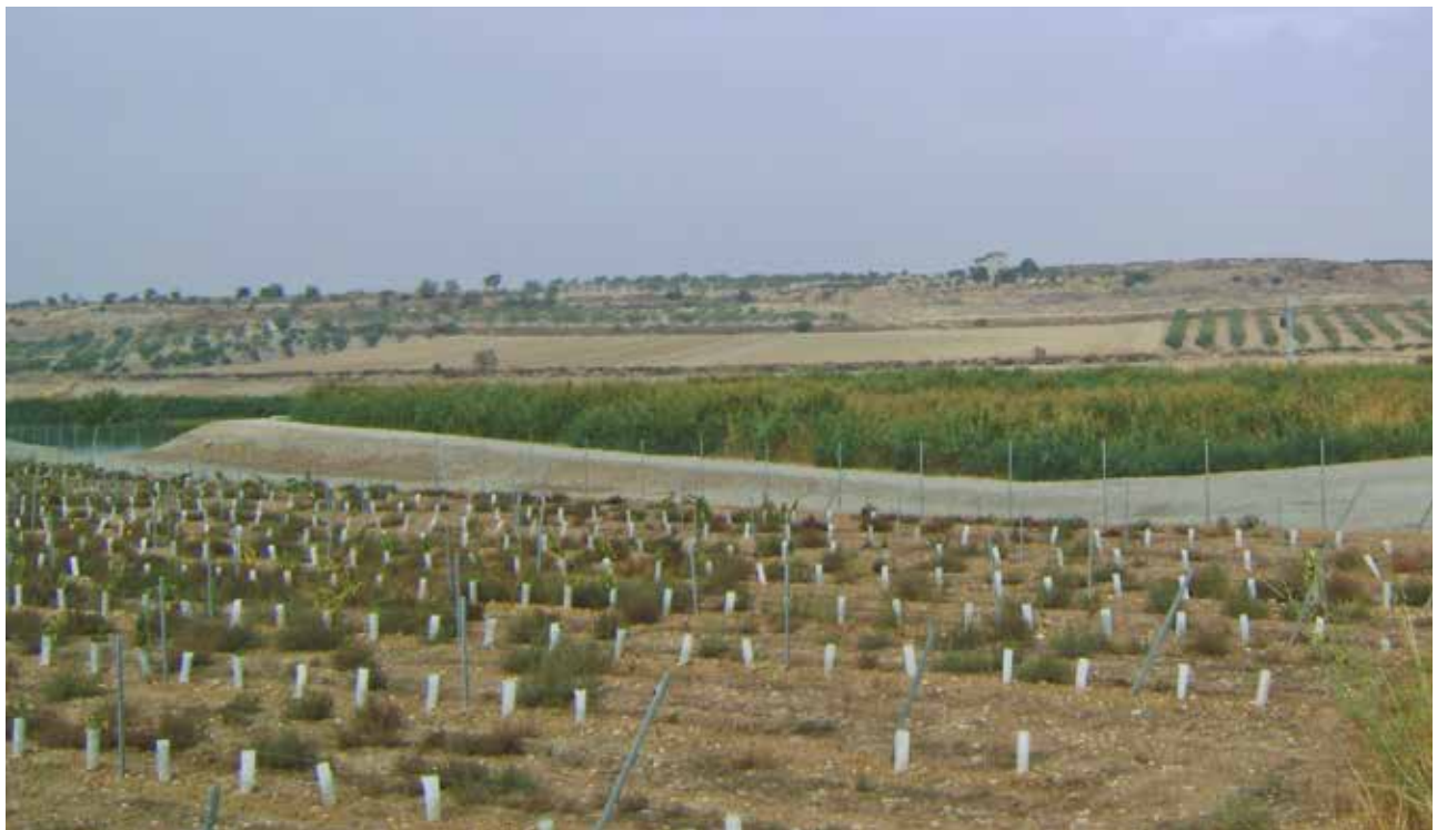
Figura 10 Vista general de la PTAS Verdú rodeada por terrenos agrícolas. Fuente: Elaboración propia
