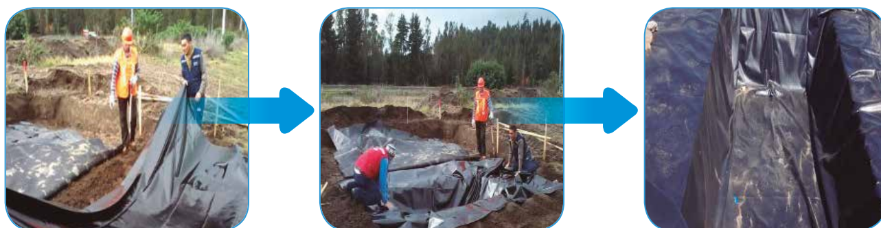
Figura 14. Impermeabilización de las celdas de los humedales construidos. Fuente: Elaboración propia
