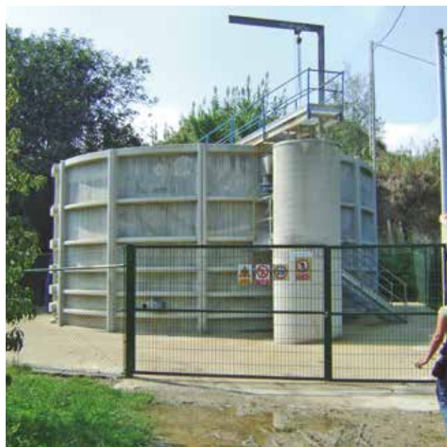
Figura 7. Tanque Imhoff utilizado en la PTAS Corbins. Fuente: Elaboración propia
