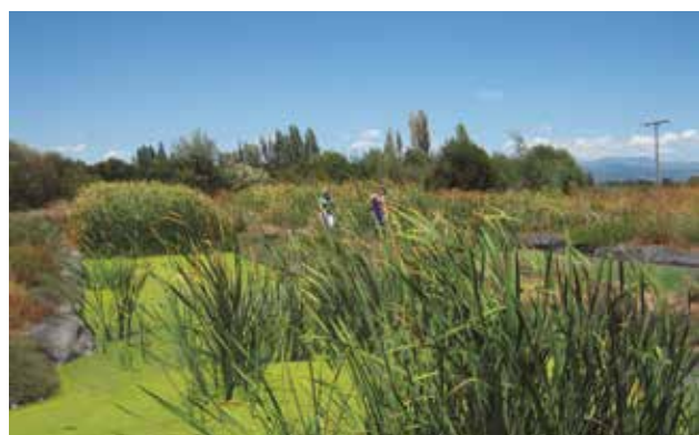
Figura 10. Sistema de humedales construidos de flujo superficial para el tratamiento de purines de cerdo. Fuente: GIBA-UDEC, 2011.
