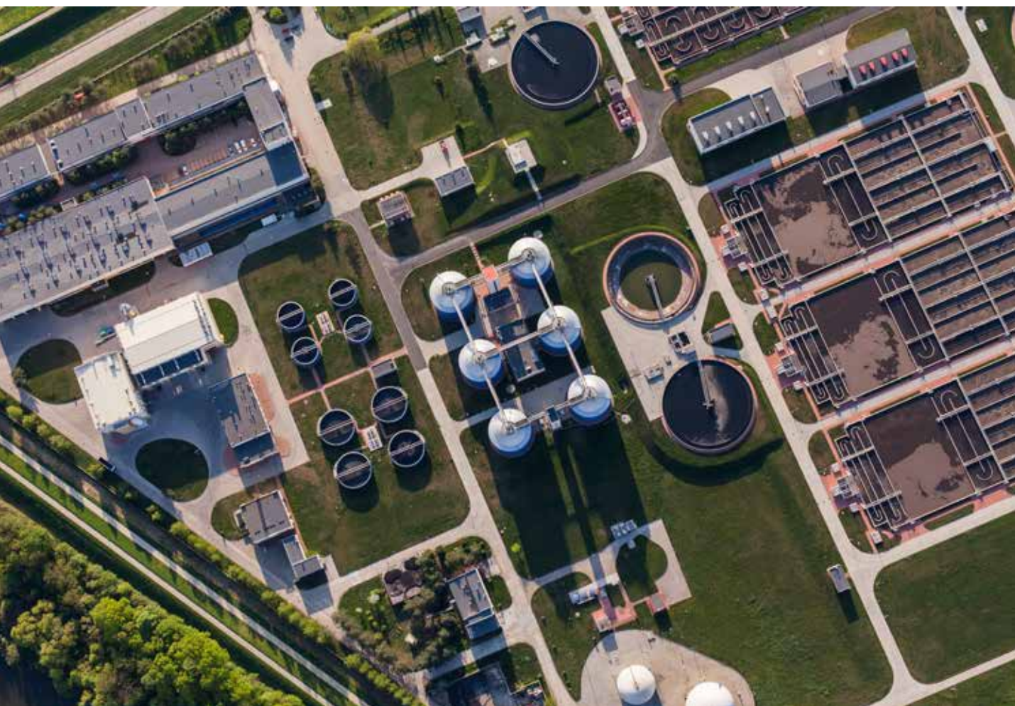
Vista aérea de una planta depuradora de aguas residuales Fotografía: © iStock.com/Mariusz Szczygiel
