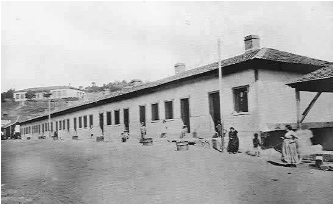
Figura 1.2-1: Fotografía de Antiguo Pabellón Obrero, sector Puchoco
