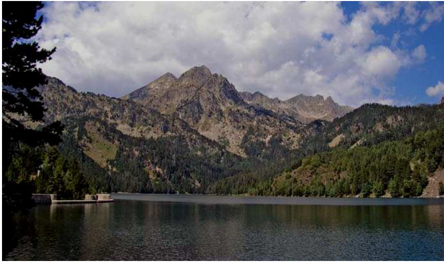
Figura 8. 54. Presa para el aprovechamiento hidroeléctrico en el Estany de Sant Maurici
