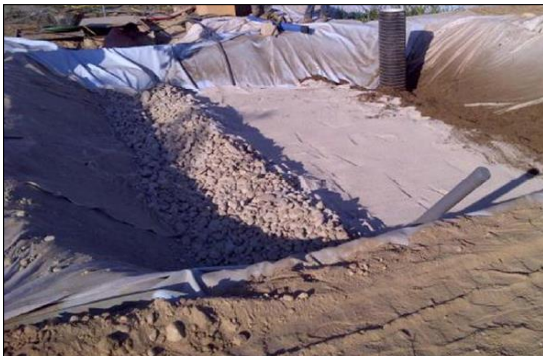
Figura 3.5. Estructuras de entrada y salida.
