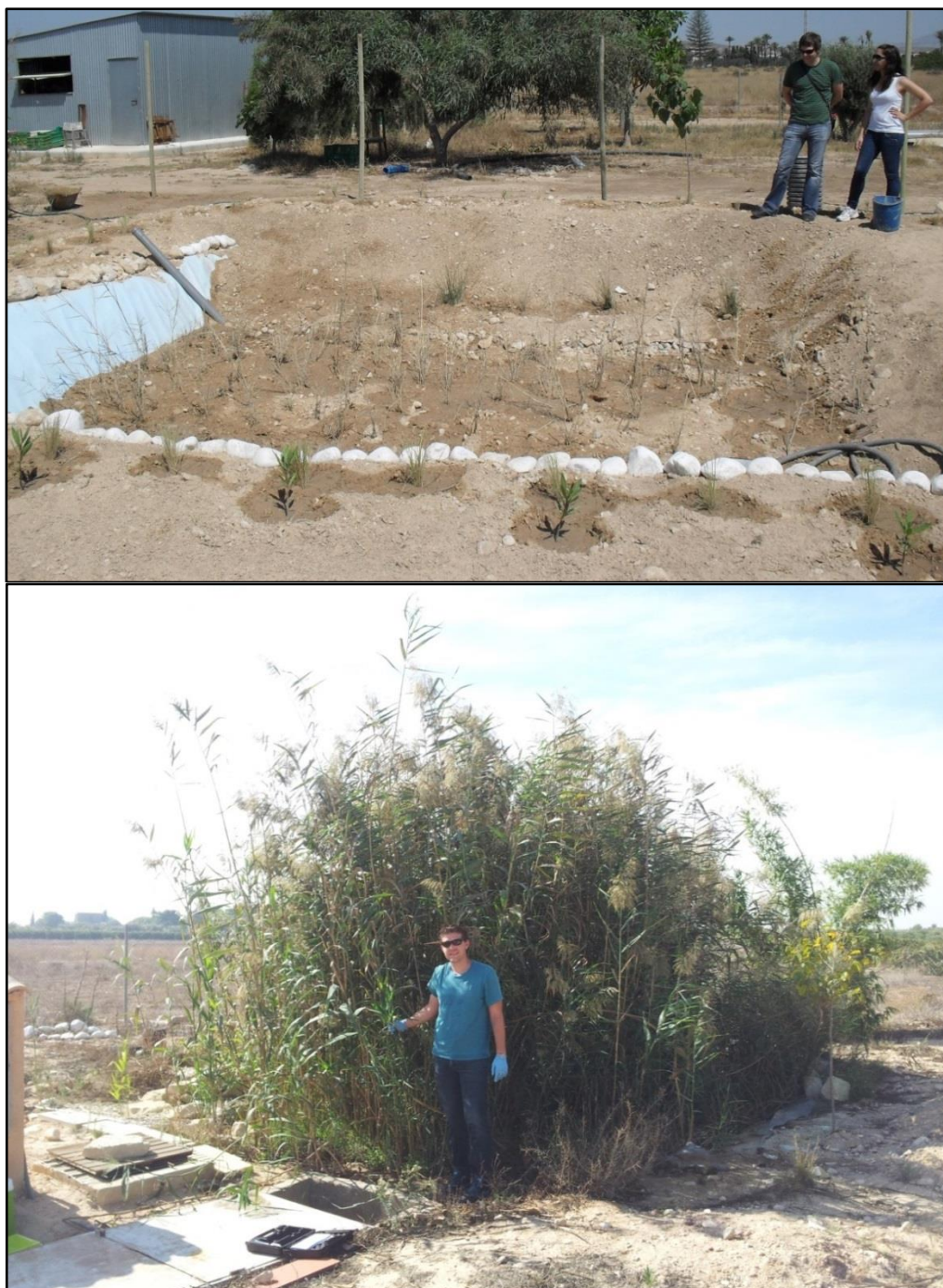
Figura 3.4. Humedal construido de flujo subsuperficial horizontal al inicio (arriba) y tras el desarrollo de la vegetación (abajo).
