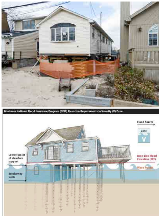
Figura 8.107 Breezy Point, N.Y., 22 de marzo de 2013 – Los residentes de este barrio en Queens están reconstruyendo los hogares que fueron destrozados por el huracán Sandy. Esta vivienda está siendo elevada al nuevo nivel de inundación para prevenir daños en futuras inundaciones.
