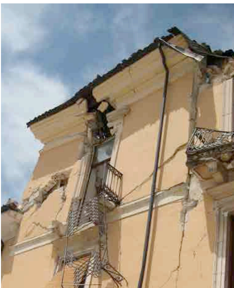
Figura 5.67 Daños estructurales. L'Aquila 2009. Fotos propias del autor.
