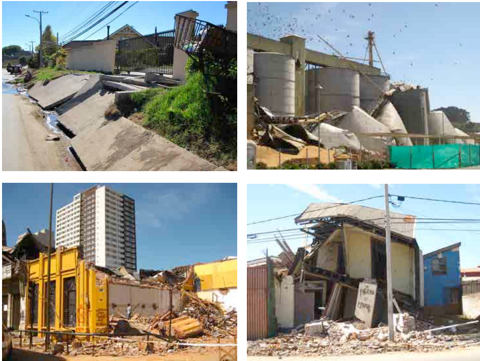
Figura 6.59-6.60 Calle levantada en Concepción y silos de molinera. Figura 6.61- 6.62 Edificios derrumbados en el centro de la ciudad de Concepción - Fotos propias del autor
