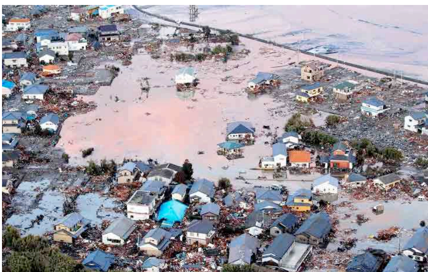
Figura 7.52 Case distrutte dalle inondazioni dello tsunami a seguito del terremoto di Tohoku in prossimità della città di Iwaki, prefettura di Fukushima, il Giappone. 11 marzo 2011. Fuente: EPA/BGNES
