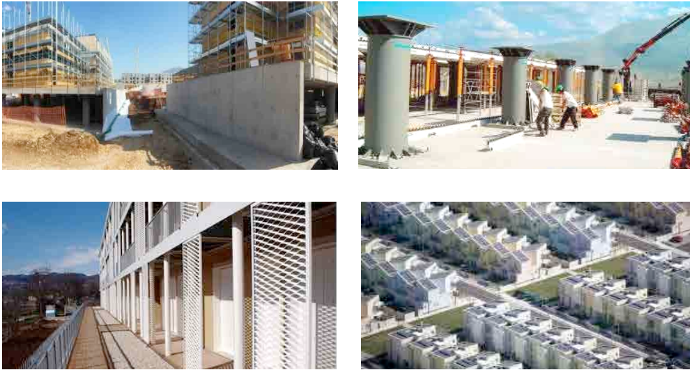
Figura 5.77 Panorámica de la obra del plano C.A.S.E. en el área de San Antonio.
