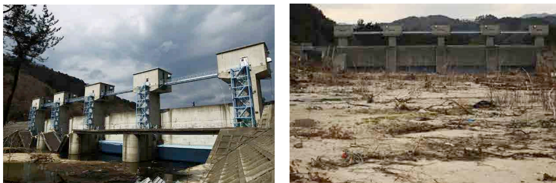
Figura 7.6-7.7 Muro de protección y puerta móvil de Fudai de 15,50 metros de alto y 205 m de ancho. Antes y después del tsunami.
