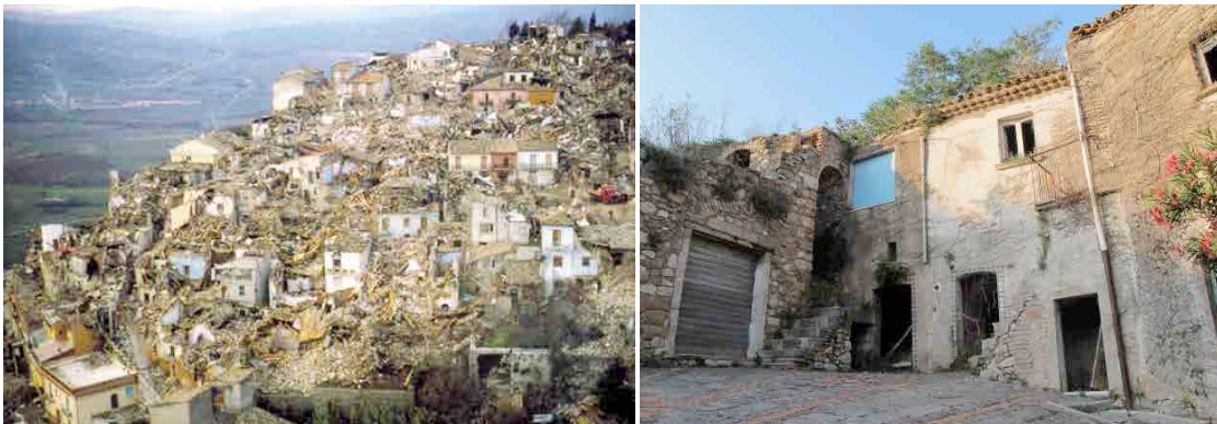
Figura 5.44-5.45 Conza después del terremoto. Fuente: Raccontiviandanti
