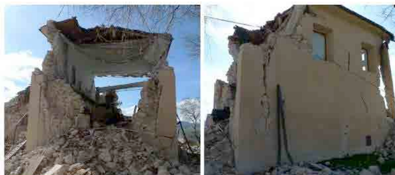
Figura 5.68-5.69 Colapso casa de ladrillos – Aquila 2009
