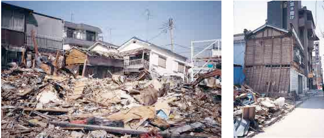
Figura 7.21-7.22 Casas derrumbadas en el terremoto de Kobe, Japon 1995.
