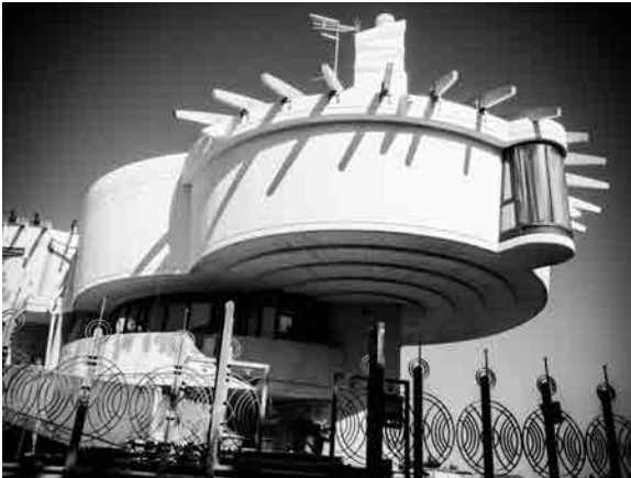
Figura 5.36 Casa privada con al lado el almacén del vendedor de materiales de construcción. Hormigón teñido de blanco que se eleva en cilindros planos y concéntricos en Bisaccia Nueva. Foto Andrea Semplici.
