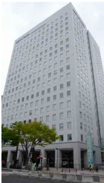
Figura 7.53 MT Building (Sendai, 18 piani): il sistema d'isolamento (RB + SD) ha ridotto a_{o,max} da 0,23 e 0,31 g alla base a 0,19 g alla sommità ( S_{o,max} = 23 cm) Figura 10: National Western Art (Le Corbusier) Museum di Tokyo (4 piani), adeguato sismicamente con HDRB in sottofondazione nel 1999: il sistema d'isolamento ha ridotto a_{o,max} da 0,19 e 0,28 g alla base a 0,08 e 0,10 g alla sommità.
