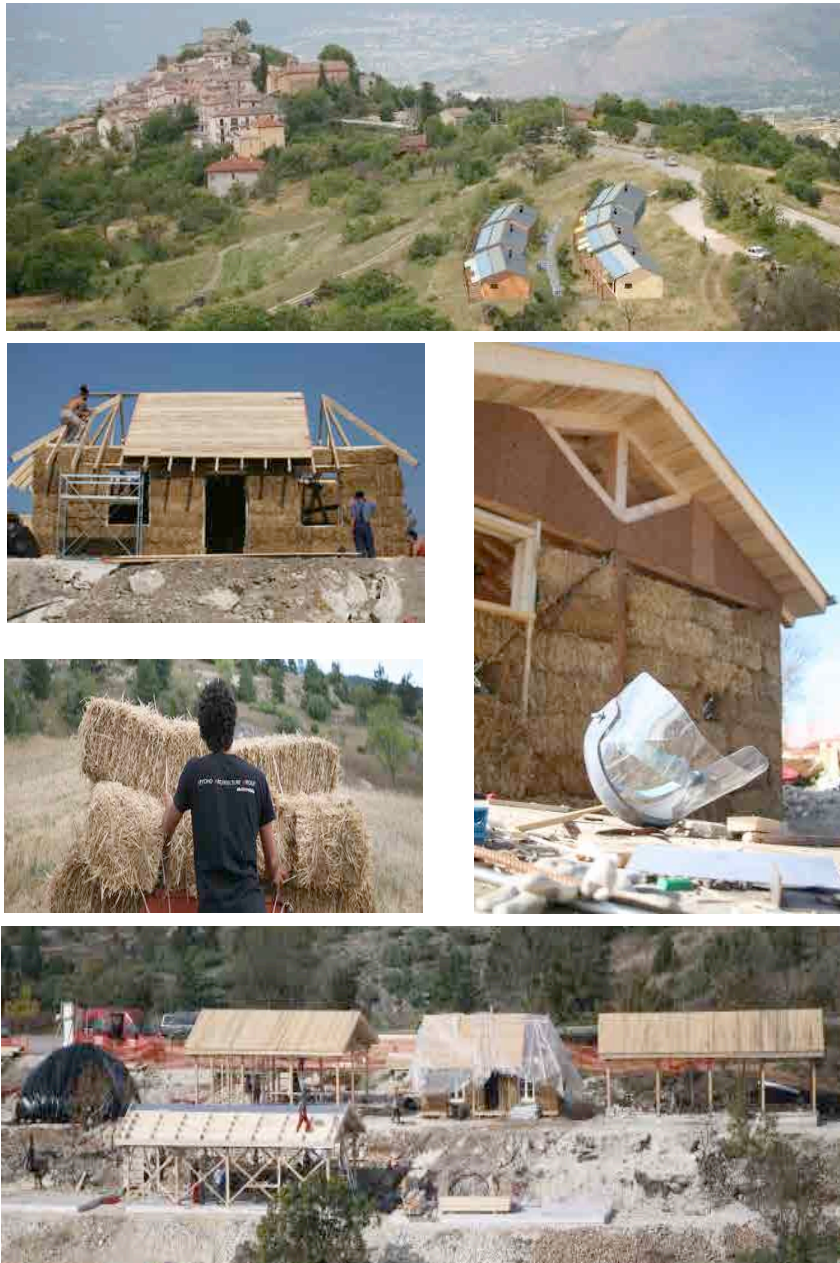
Figura 5.92 Fases de la construcción de las casas prefabricadas de Pescomaggiore. Fotos proporcionadas por BAG - Beyond Architecture Group
