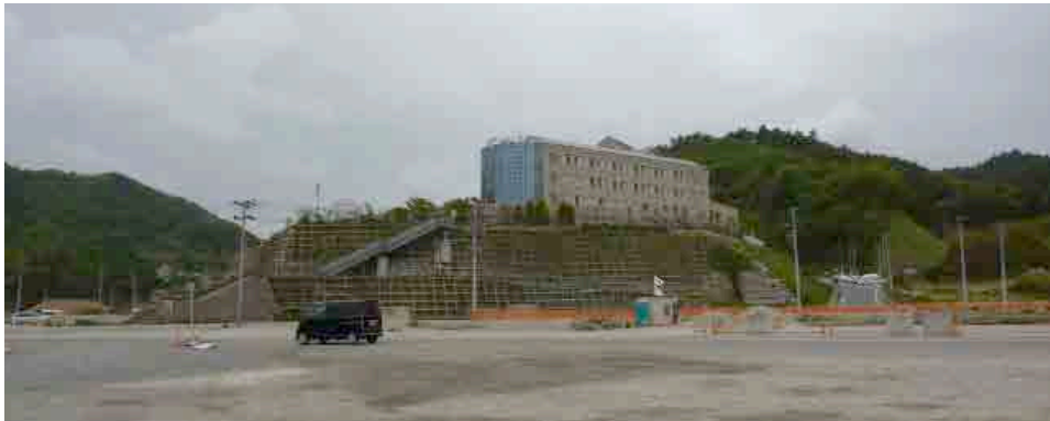
Figura 7.44 Ospedale di Tohoku costruito su un terrapieno di 15 metri.
