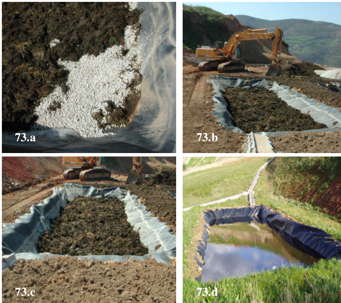
Fig 73. Vistas de la primera celda (anaerobia) del tratamiento: Fig 73.a. Detalle de las capas de relleno: estiércol (superior) y grava (inferior) Fig 73.b. Proceso de llenado de la celda Fig 73.c. Detalle de la celda, una vez rellena Fig 73.d. Celda anaerobia en funcionamiento
