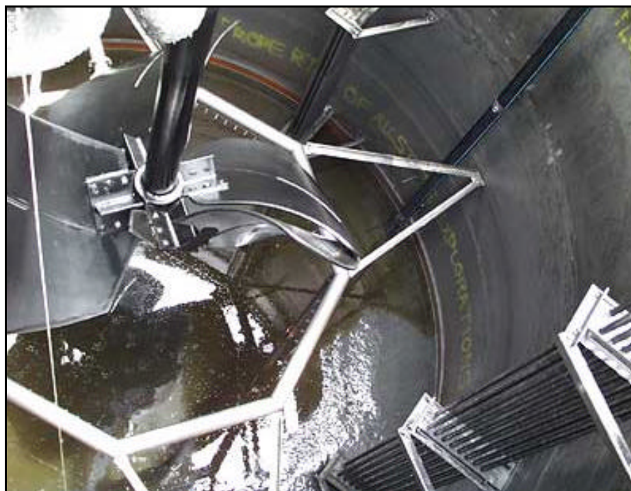
Fig. 26. Detalle interior de los tanques de la figura anterior (mina Beaconsfield)
