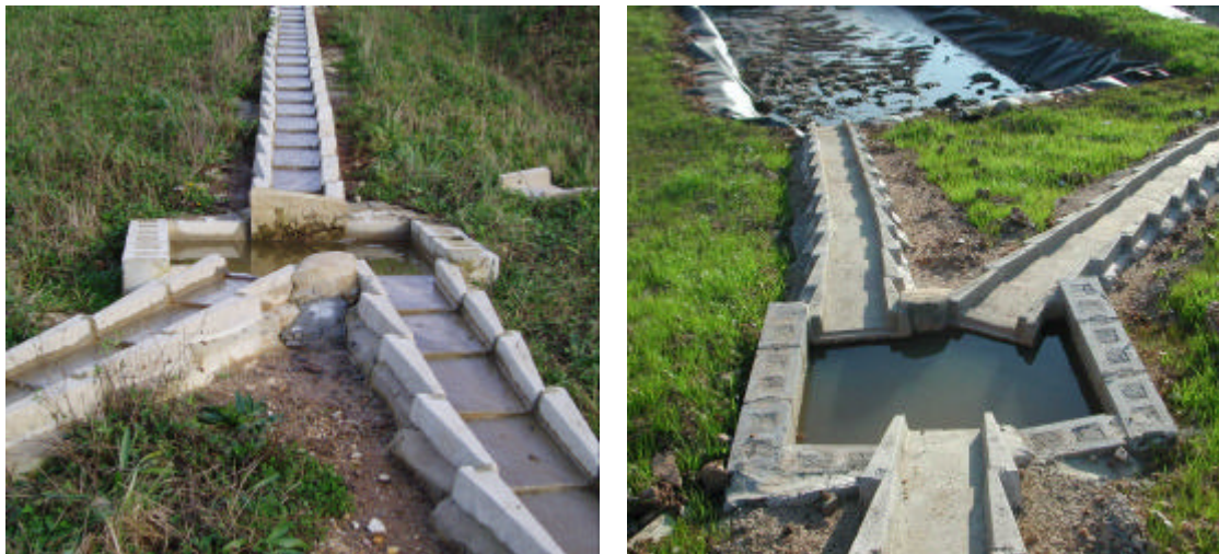
Fig. 70. Vistas de la balsa que sirve de distribución del caudal a las dos líneas del sistema.
