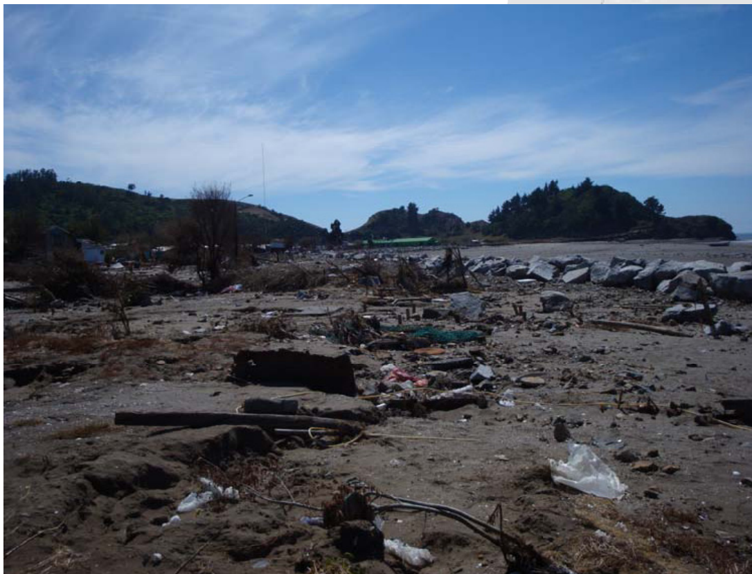
Fig.4 Caleta Tubul. Se observa el enrocado desplazado por el tsunami.
