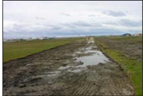
Fotografía 70: Construcción terraplén, 2005, (Jaime Carcamo)
