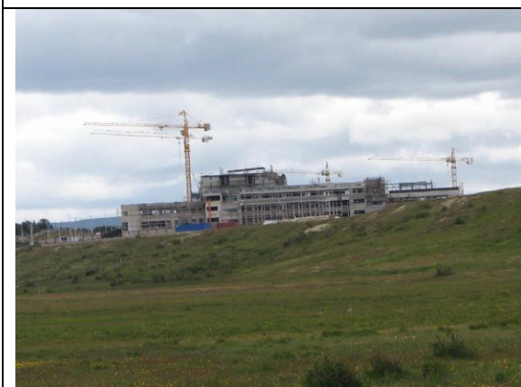
Foto Nº 5. Hospital en construcción.
