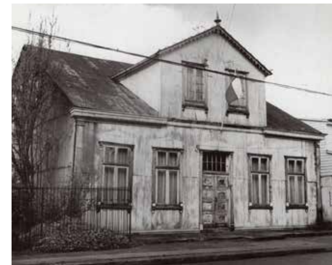
Construcción Europea en Valdivia Valdivia en madera y metal, Mariana Matthews
