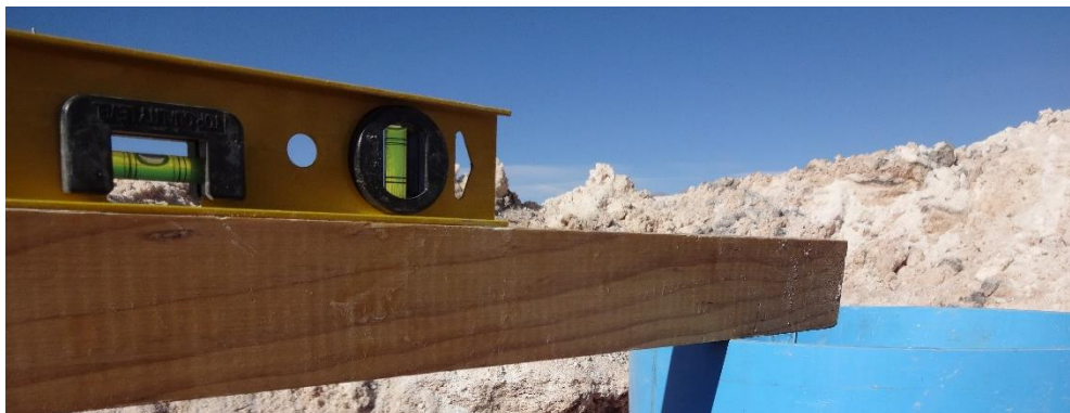
Figura-11: Nivelación de lisímetro y estanque.
