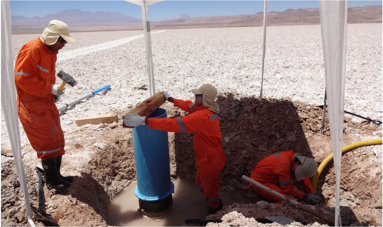
Figura-4: Proceso de hincado
