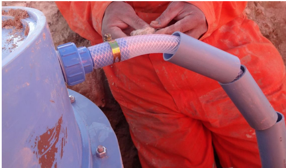
Figura-9: Instalación de manguera de conexión.
