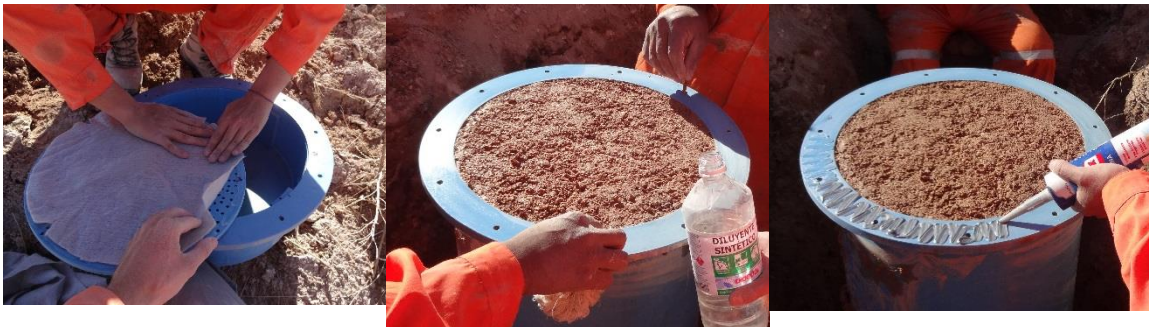
Figura-8: Tapa con filtro de arena, geotextil y disco perforado (izquierda). Preparación y limpieza de la brida superior (centro). Aplicación de silicona para el sellado de la unión entre bridas (derecha).
