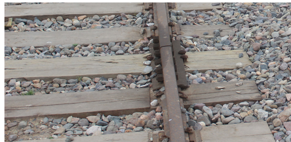
Durmientes de ferrocarril para barandas de la pasarela. Archivo personal (2016).
