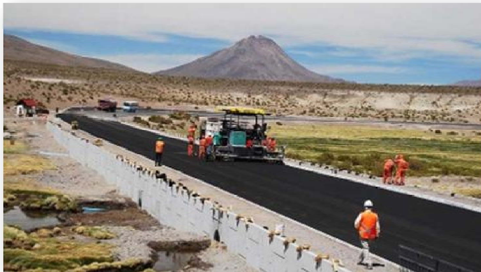
FOTO 4: Construcción del puente del río Isluga (Fotografía: El Boyaldí) publicado en La Razón Digital, 3 de Enero de 2012.
