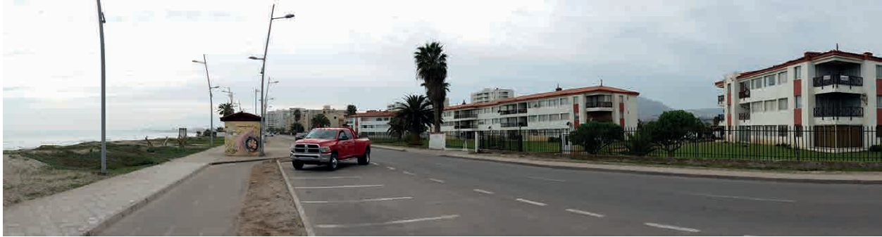
40 Figura 8 Primeros edificios de la Avenida del Mar. Fuente: archivo personal de los autores.
