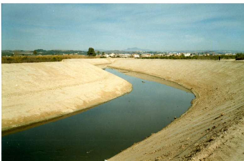
Figura 100. Encauzamiento del Río Segura a su paso por Rincón de Beniscornia. Obras terminadas al inicio de los años 90.
