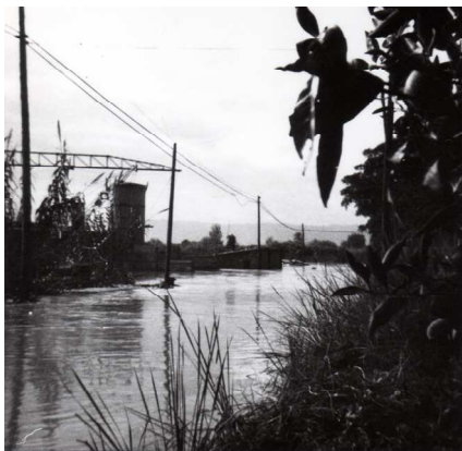
Figura 95. Inundación en Rincón de Benisornia. Carretera de la Ñora en la Vuelta del Río.
